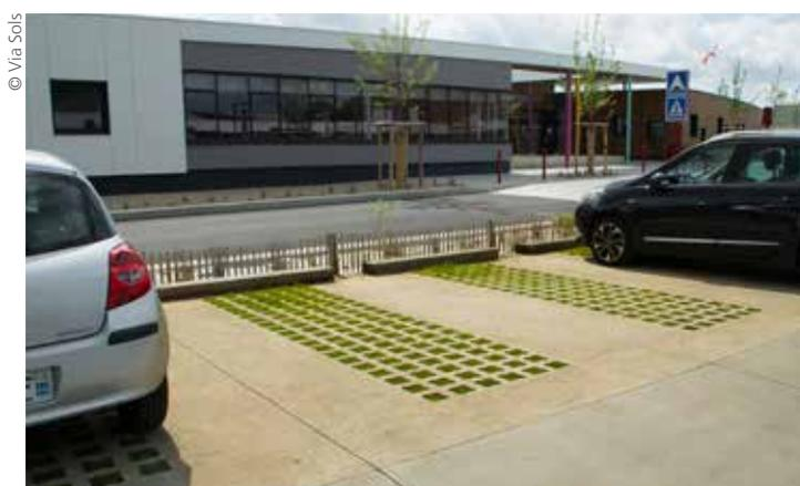
Les places de stationnement sont recouvertes d'un revêtement en béton monolithique, garanti sans orniérage ni fluage. Remplies d'un mélange terre-pierres et semées de gazon, les alvéoles assurent la perméabilité du sol et limitent ainsi l'engorgement des réseaux d'évacuation.
