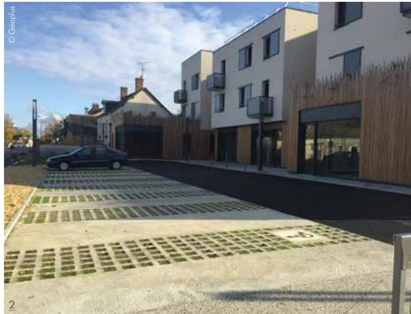
1/ Les places de stationnement sont recouvertes d'un revêtement en béton monolithique, garanti sans orniérage et fluage. Remplies d'un mélange terre-pierres et semées de gazon, les alvéoles assurent la perméabilité du sol et limitent ainsi l'engorgement du réseau d'eaux pluviales.
