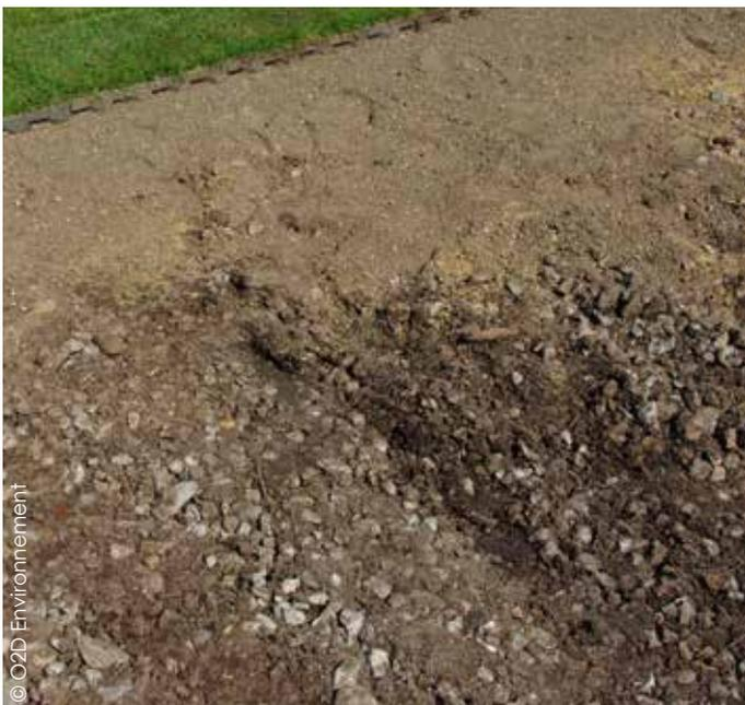
La bonne réalisation de la couche de fondation drainante est gage de la bonne infiltration des eaux. D'une épaisseur moyenne de 15 à 30 cm, elle se compose de 70 % de pierres concassées (20/40 ou 30/60) et de 30 % d'un mélange terre/terreau pour rester fertile.
